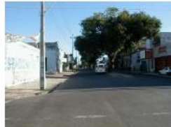
CRUZAMENTO AV. IMPERADOR C/ SPONADOR ALBUQUERQUE - VISÃO SUL
